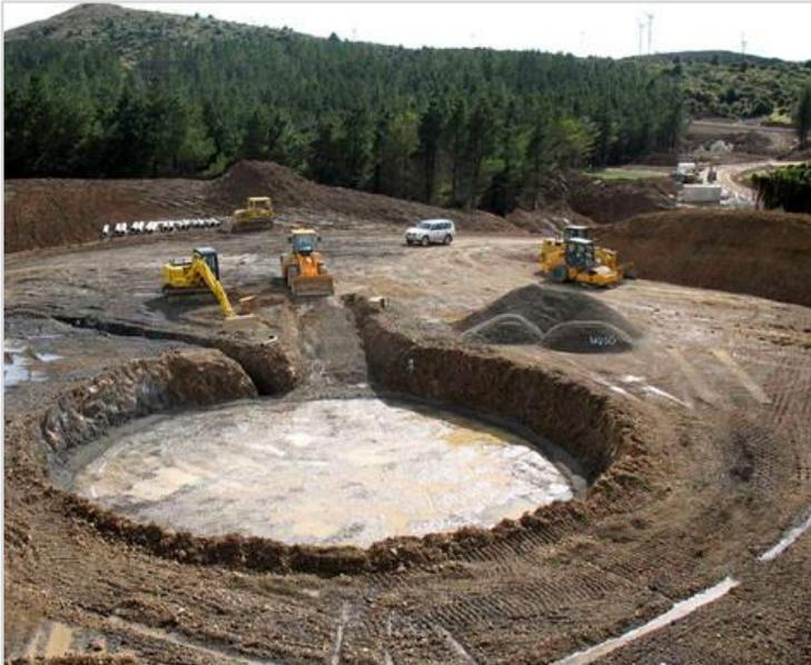
*Environ 500 m<sup>3</sup> (1200 t) de béton pour une fondation d'éolienne (60 à 100 camions toupies)*
