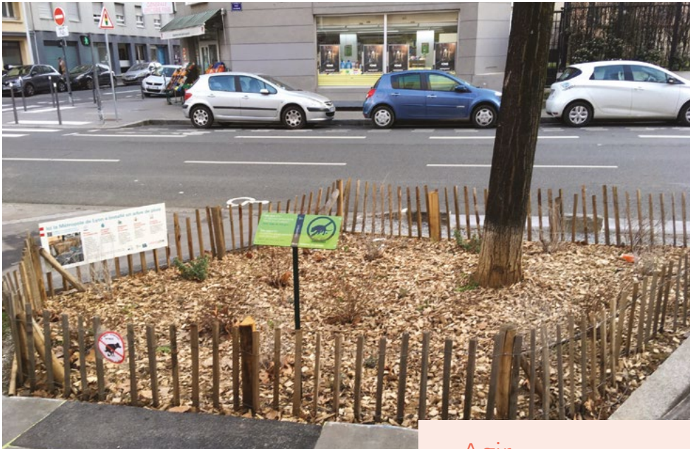
→ Dans la Métropole de Lyon, la transformation des arbres en arbres de pluie permet de déconnecter les eaux pluviales du réseau d'assainissement.
