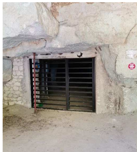
GRILLE DEVANT LA CAVE DES CHALONS PERMETTANT LE PASSAGE DES CHIROPTERES
