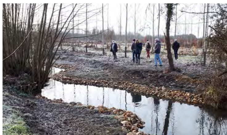
Visite de travaux sur la Veude, affluent de la Vienne, à Jaulnay (37)
