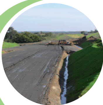
Sol imperméabilisé © A. Bispo, ADEME
