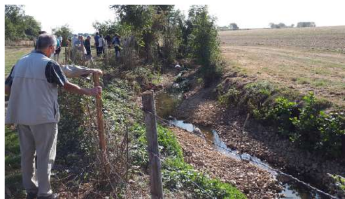
Visite de travaux sur la Sonnette, sous-affluent du Loir (Les Autels-Villeuillon 28)
