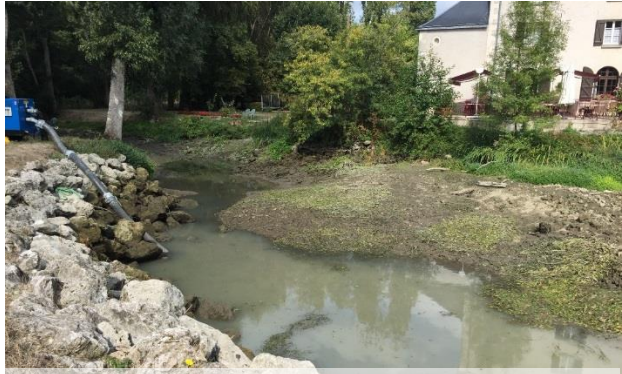
Démolition du déversoir et pompage de la rivière (avec pêche de sauvetage)
