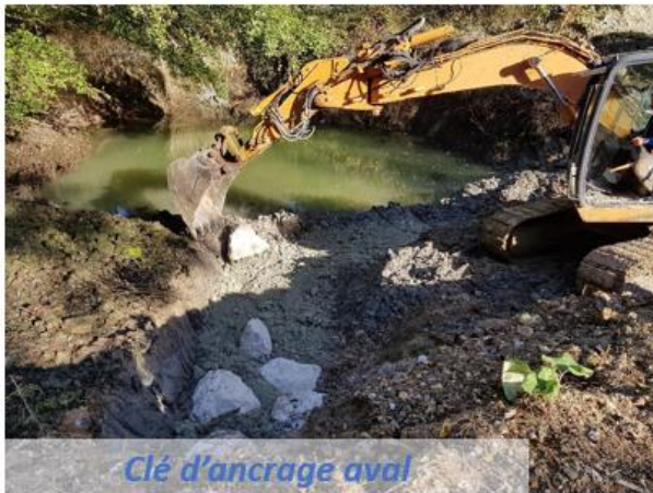
Enrochements sur argile
