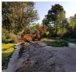
Création de banquettes végétalisées (argiles : 2000 m 3 – blocs : 110 m 3 )
