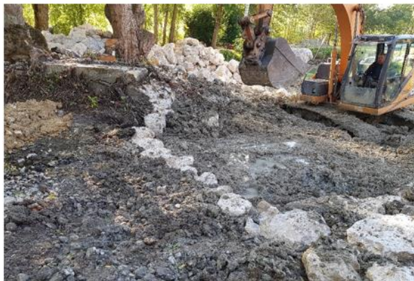
Ancrage amont et aval de la rampe – profondeur 1,5 m
