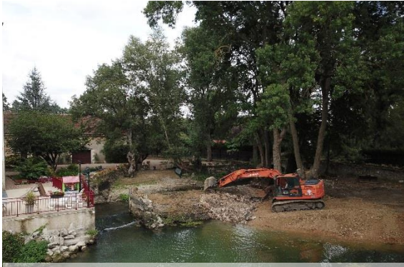
Démolition du déversoir et pompage de la rivière (avec pêche de sauvetage)
