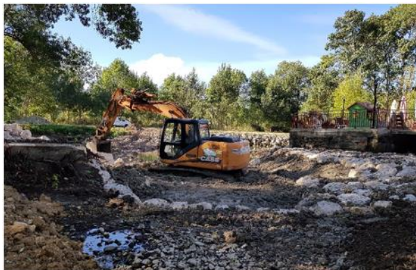
Mise en place des blocs sur lit d'argile
