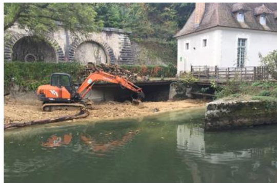
Création de banquettes végétalisées (argiles : 2000 m 3 – blocs : 110 m 3 )
