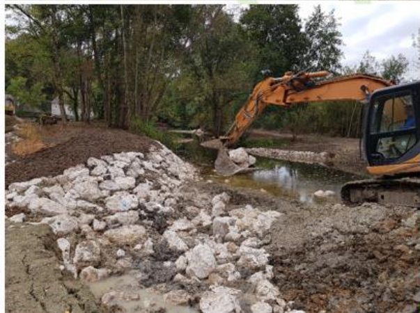
Enrochements sur argile
