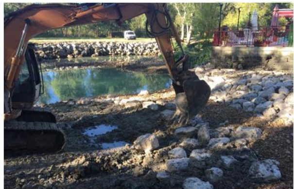
Mise en place des blocs sur lit d'argile
