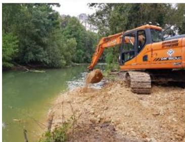
Création de banquettes végétalisées (argiles : 2000 m 3 – blocs : 110 m 3 )
