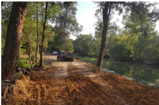
Création de banquettes végétalisées (argiles : 2000 m 3 – blocs : 110 m 3 )
