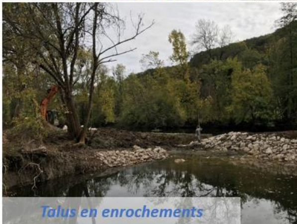
Clé d'ancrage aval
