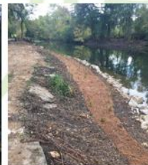
Mise en place de la terre végétale, d'un toilage biodégradable
