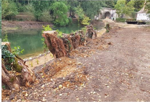
La végétation après travaux
