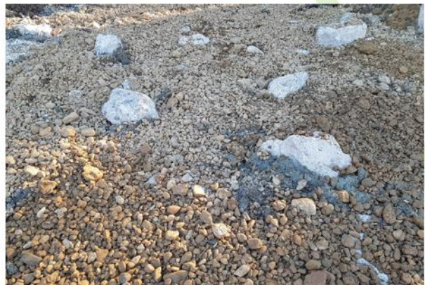
Mise en place des blocs sur lit d'argile
